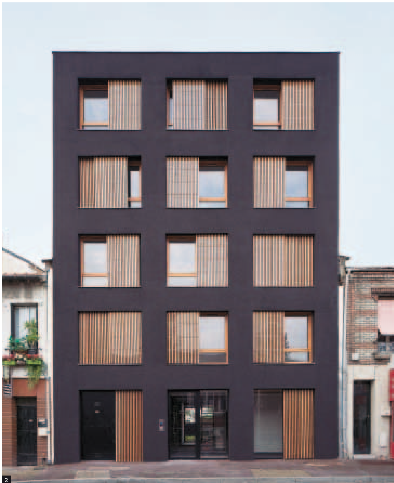
1 - Les T1 sont mono-orientés sur le jardin. Au-dessus se trouvent les duplex traversants. 2 - Côté rue, la façade est revêtue d'un enduit gris, puis d'une peinture noire pour mieux résister au soleil. La quincaillerie des volets en bois coulissants est cachée dans une gorge.
